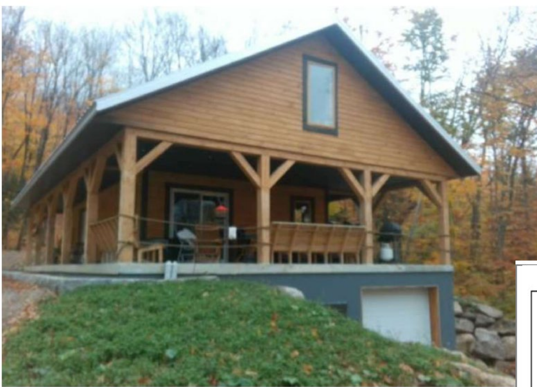
Façade avant de la maison
